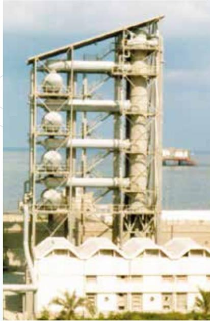
Brückenbauweise mit separatem Stahlbau, Variante einer 2-Turmbauweise, 4-stufig, Gleichstrom
