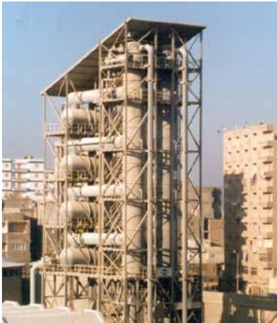
28 MW Dampfstrahl-Kälteanlage in Ägypten, Kühlung von 1 600 m<sup>3</sup>/h von 35 °C auf 20 °C
