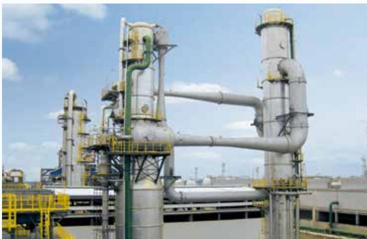
24 MW Dampfstrahl-Kälteanlage Petro China/Sichuan-Raffinerie, Kühlung von 2 300 m<sup>3</sup>/h von 29 °C auf 20 °C
