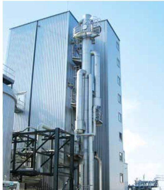
Ca. 1,4 MW Dampfstrahl-Kälteanlage in Stendal, Kühlung von ca. 72 m<sup>3</sup>/h von 25 °C auf 8 °C
