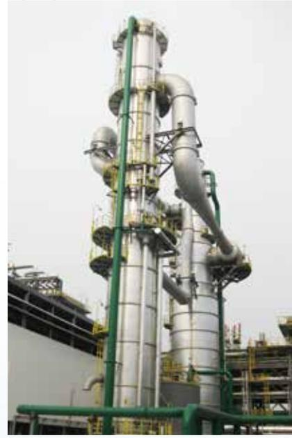
Brückenbauweise freitragend (ohne separaten Stahlbau), 2-Turmbauweise, 3-stufig, Gegenstrom
