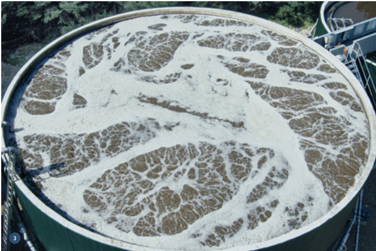
3/4) 1.200 m 3 Belebungsbecken einer Papierfabrik in Deutschland
