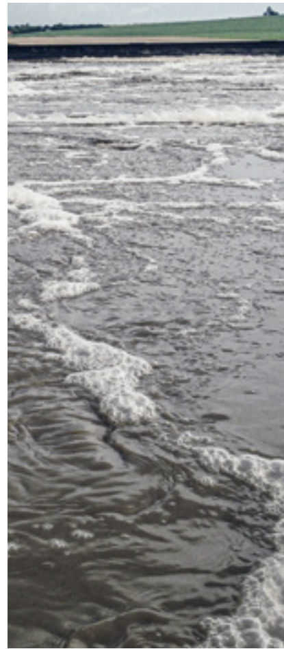
Siebenstrahlige Ejektoren in einem 2.200 m 3 Belebungsbecken in der Speiseölindustrie in Brasilien
